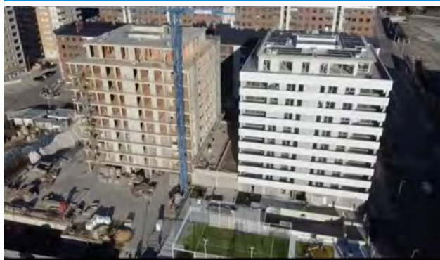
Residencial Cúbicos Viviendas
