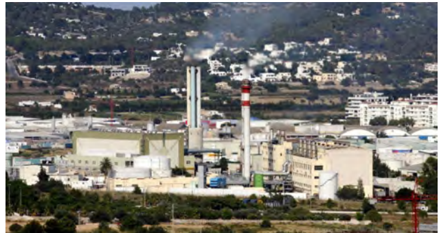
Central térmica GESA
