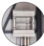
Cuadro eléctrico independiente para alimentación de luminarias, enchufe ventilación, ventilador y termostato.
